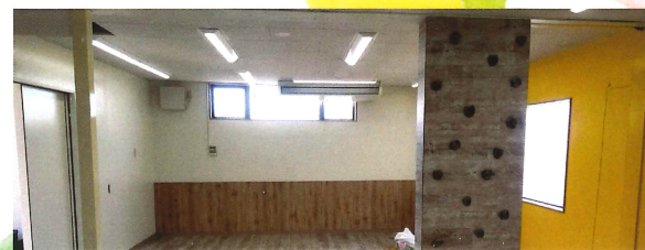
※工事中の写真です
