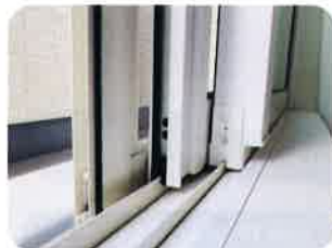
内窓の取付け
