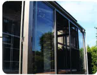
サンルームの設置
