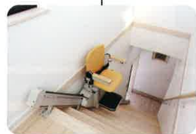
階段昇降機の設置
