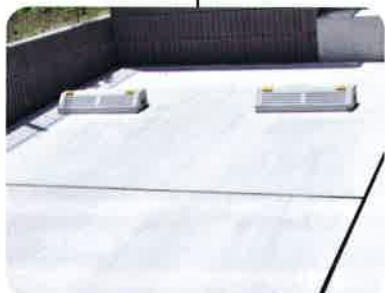
駐車場の土間コンクリート打ち
