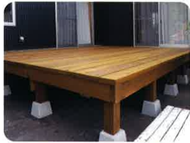
ウッドデッキの設置
